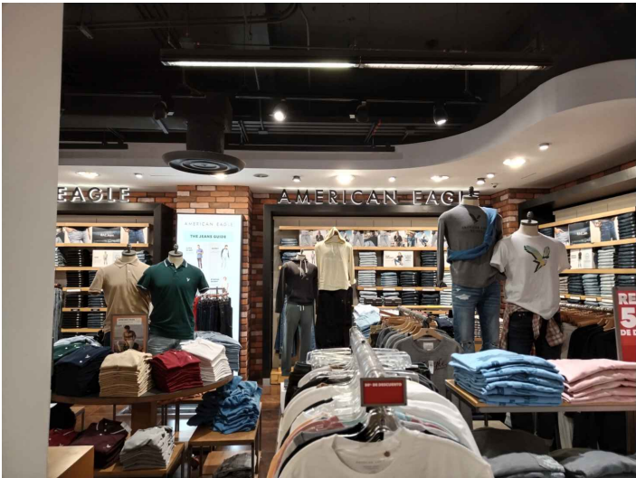
SE REQUIERE RETIRO DE MARCOS Y ACABADO DE LADRILLO EXISTENTE LIVERPOOL , CONTEMPLAR RESANE Y PINTURA A IGUALAR A LA EXISTENTE
