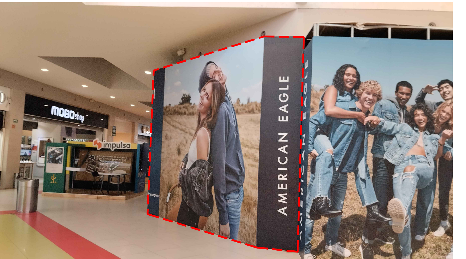
FOTOGRAFIA 3 ESTADO ACTUAL - FACHADA LATERAL
