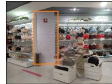
VISTA ESTADO ACTUAL
