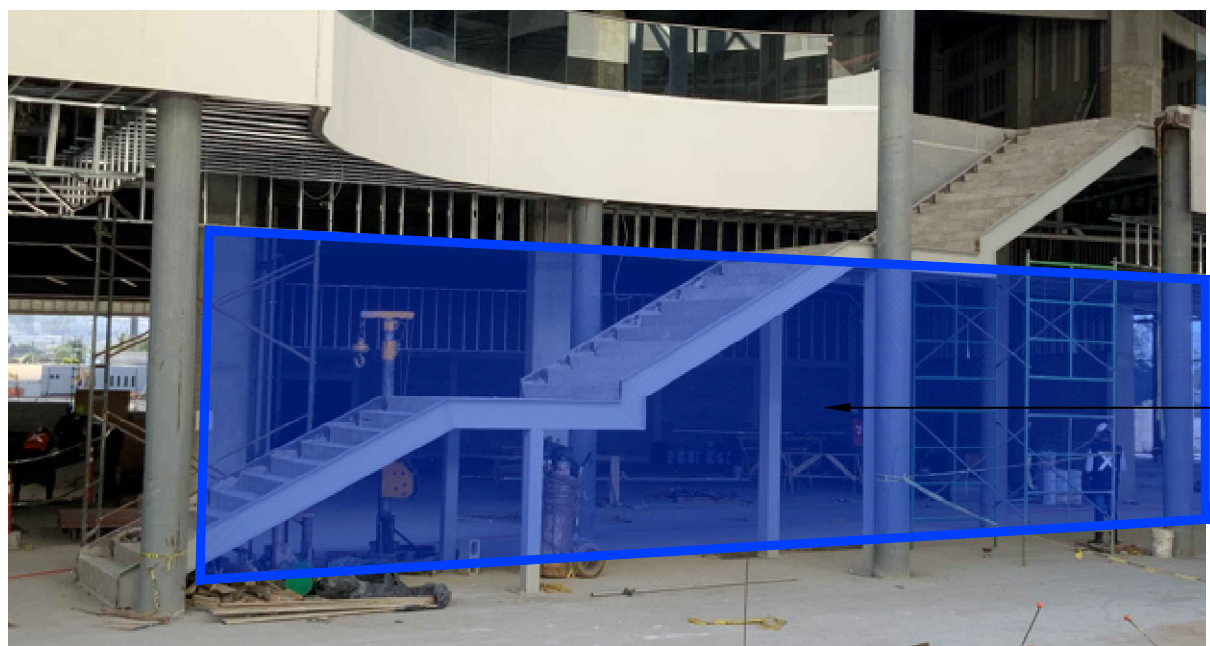
FACHADA AE DETRAS DE ESCALERAS
