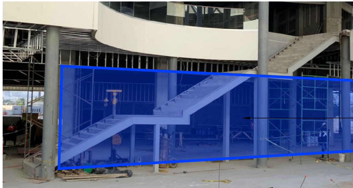
FACHADA AE DETRAS DE ESCALERAS
