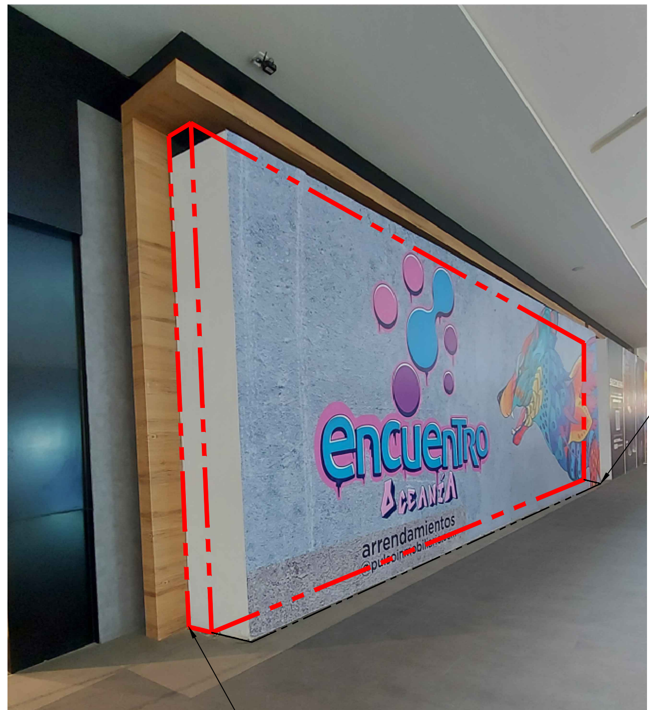
ESTADO ACTUAL FACHADA MARCO DE C.C. PRESENTA REMETIMIENTO DE LADO IZQUIERDO.
