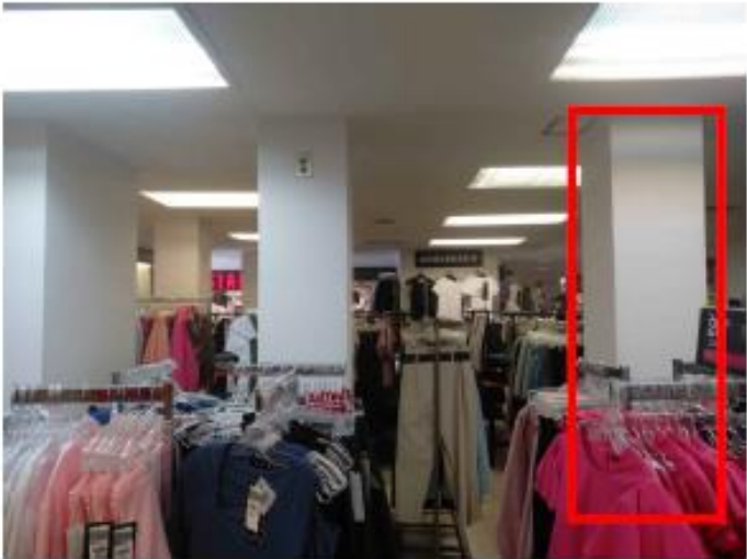
COLUMNA. ESTADO ACTUAL
