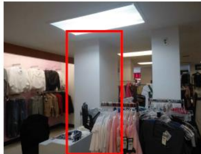
COLUMNA, ESTADO ACTUAL
