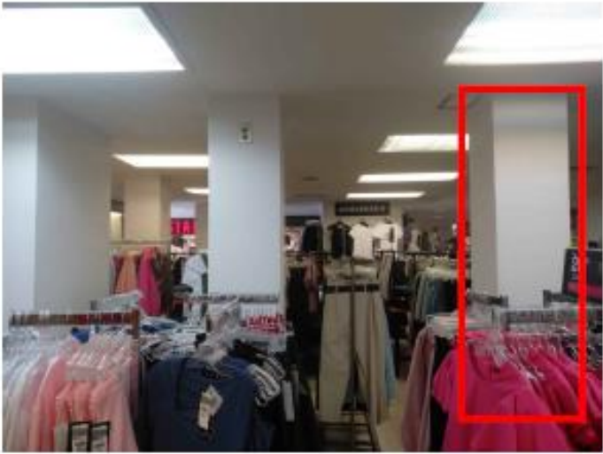
COLUMNA. ESTADO ACTUAL
