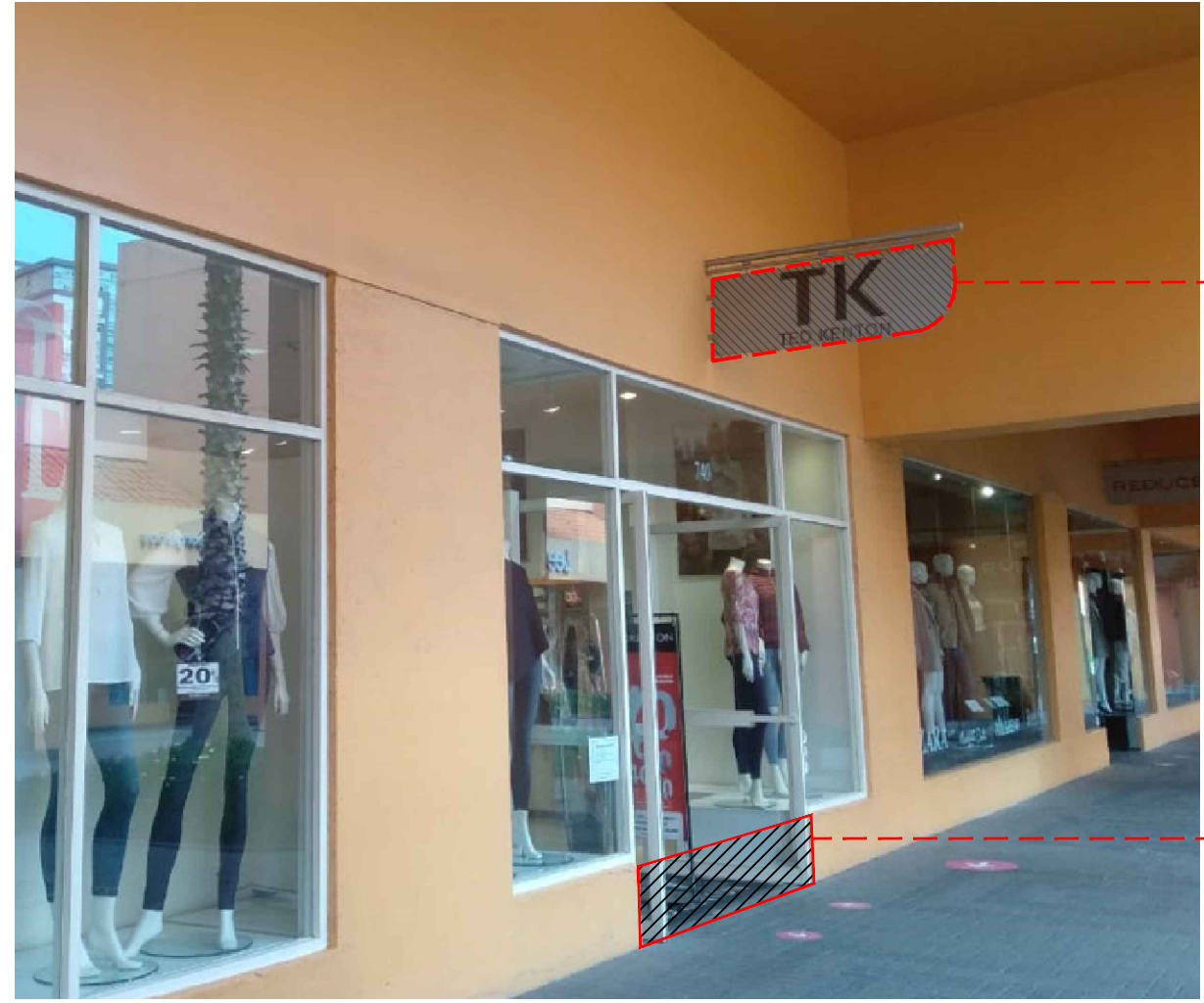
ESTADO ACTUAL DE FACHADA VISTA LADO DERECHO
