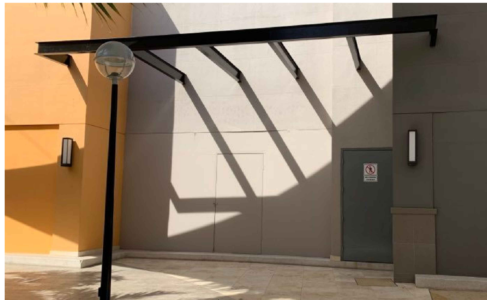
ESTADO ACTUAL FACHADA
