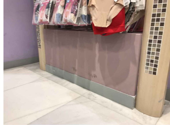
RETIRO DE BASE DE TABLAROCA EXISTENTE
