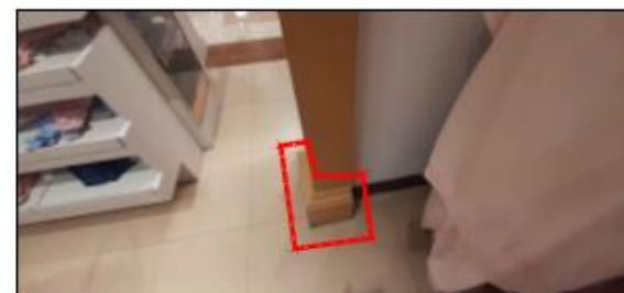
ESTADO ACTUAL - MOLDURA DE MADERA
