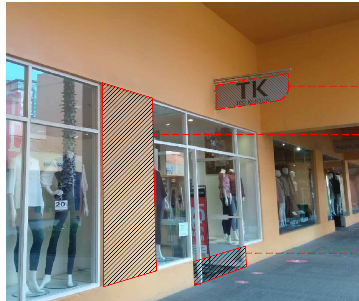
ESTADO ACTUAL DE FACHADA VISTA LADO DERECHO
