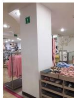
ESTADO ACTUAL COL-1
