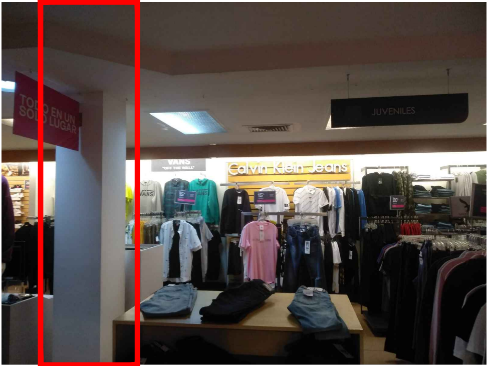
COLUMNA ESTADO ACTUAL
