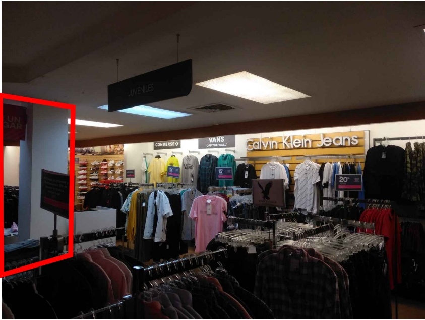
COLUMNA ESTADO ACTUAL
