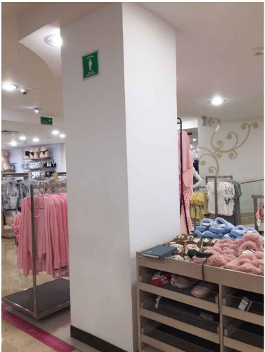
ESTADO ACTUAL COL-2
