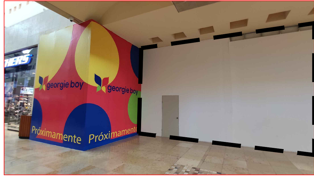
ESTADO ACTUAL DE LA FACHADA, CUBIERTA CON UN TAPIAL
